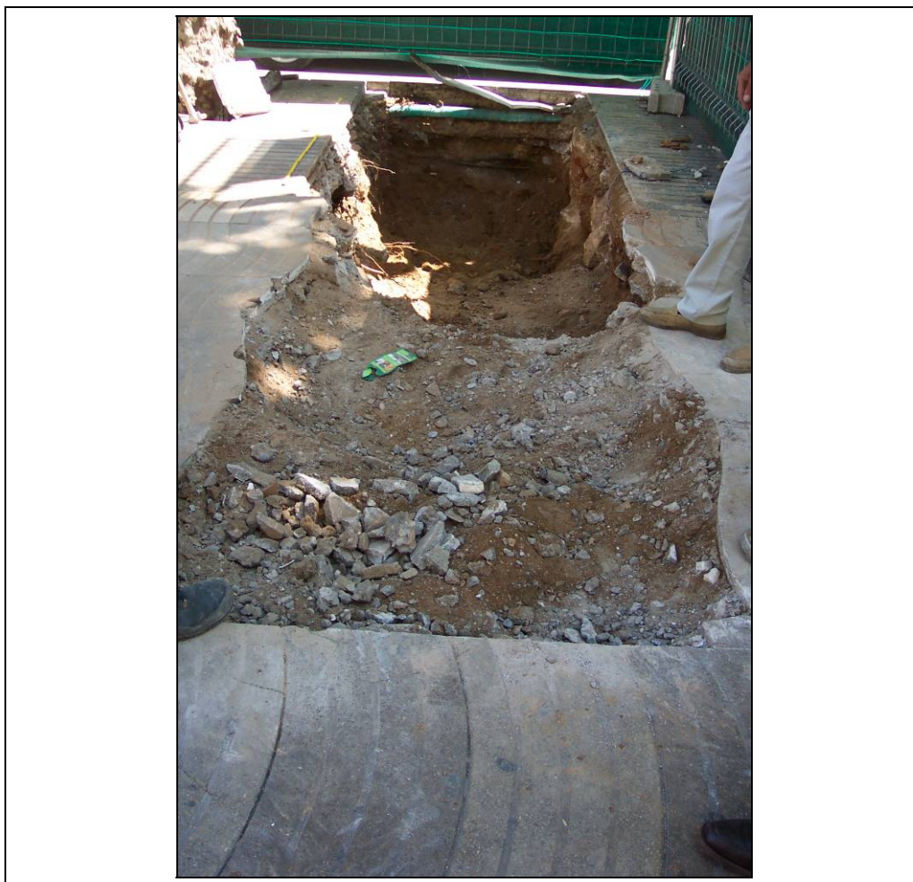
Foto 4: Rasa 2 en la intersecció amb la rasa 1
