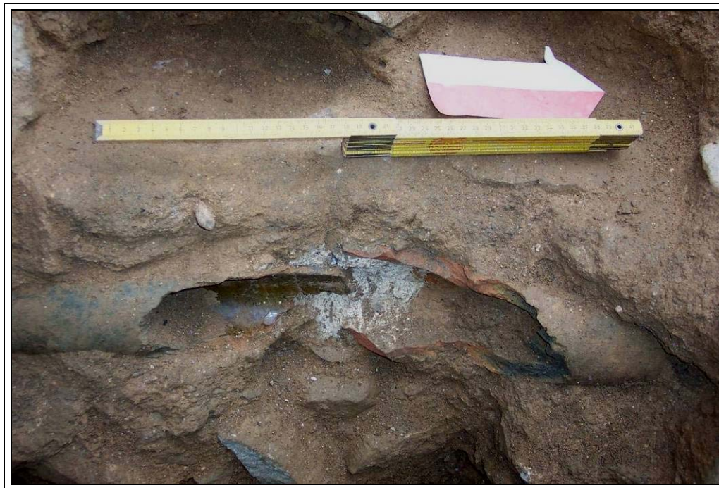
Foto 61: Detall canalització UE 359
