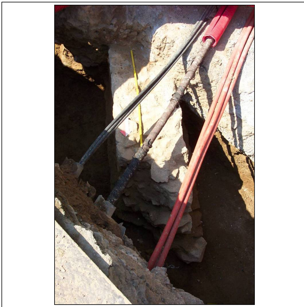
Foto 62: Mur UE 358 després del desmuntatge de la canalització UE 359
