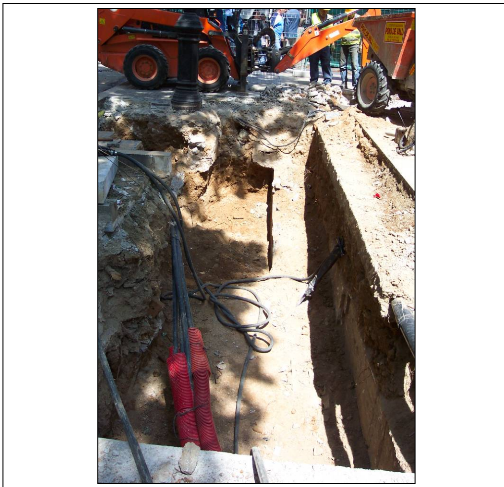
Foto 7: Rasa 2 en el tram final. A la dreta hi ha la fonamentació del metro i al sud hi ha una arqueta de formigó
