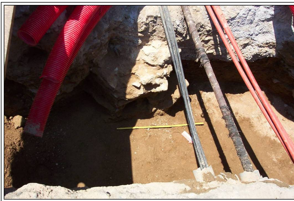
Foto 64: Desmuntatge del mur UE 358
