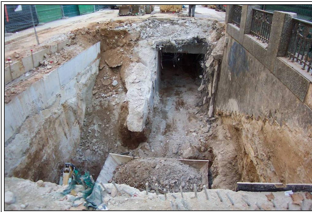
Foto 91: Segona zona d'ampliació. Eliminació d'estratigrafia que encara es conservava per sota del mur central de formigó.
