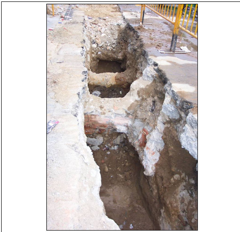
Foto 34: 4art tram rasa 3 amb nombrosos serveis
